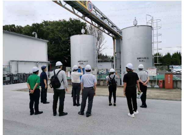
低濃度 PCB 廃油タンク前
