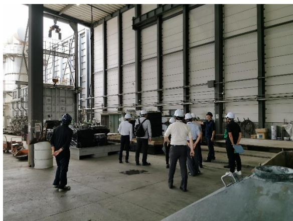
低濃度 PCB 廃棄物専用固定床炉
